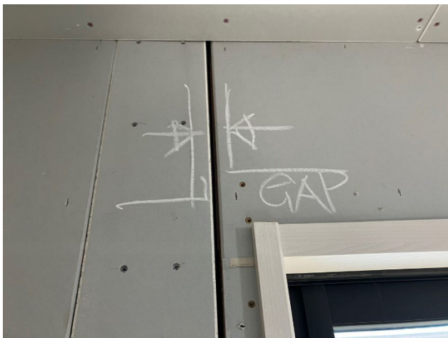
左:ボード浮き・割れ 右:ボード浮き・割れ
