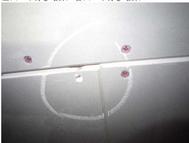
左:天井隙間 右:天井隙間
